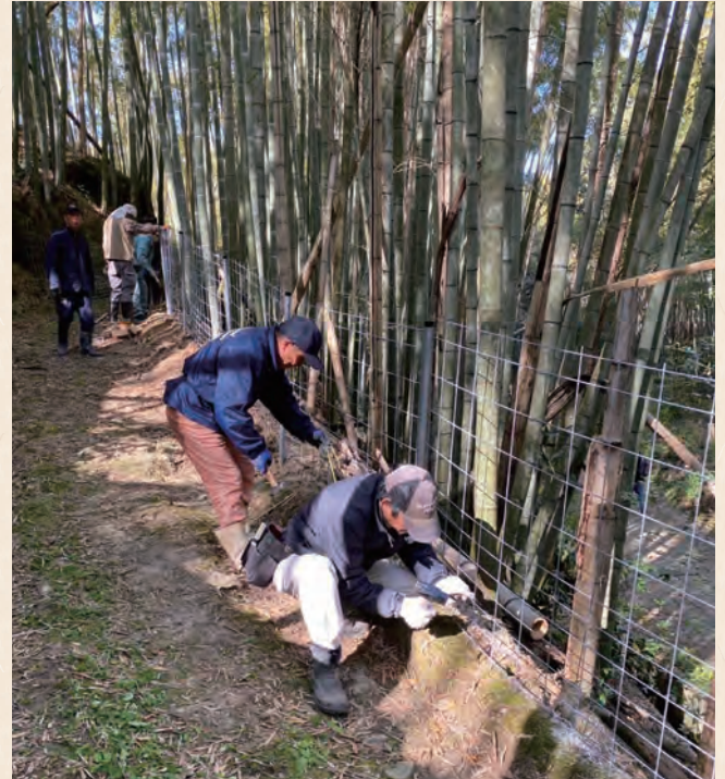
▲設置作業の様子。柵は約1キロにわたって設置されました
